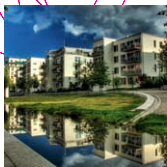
As primeiras fases de construção do Hammarby Sjöstad foram finalizadas em 2000. Haverá 25.000 habitantes e 35.000 locais de trabalho em 2015. Comparado ao ambiente do caso em referência o estresse foi reduzido em cerca de 40% .
